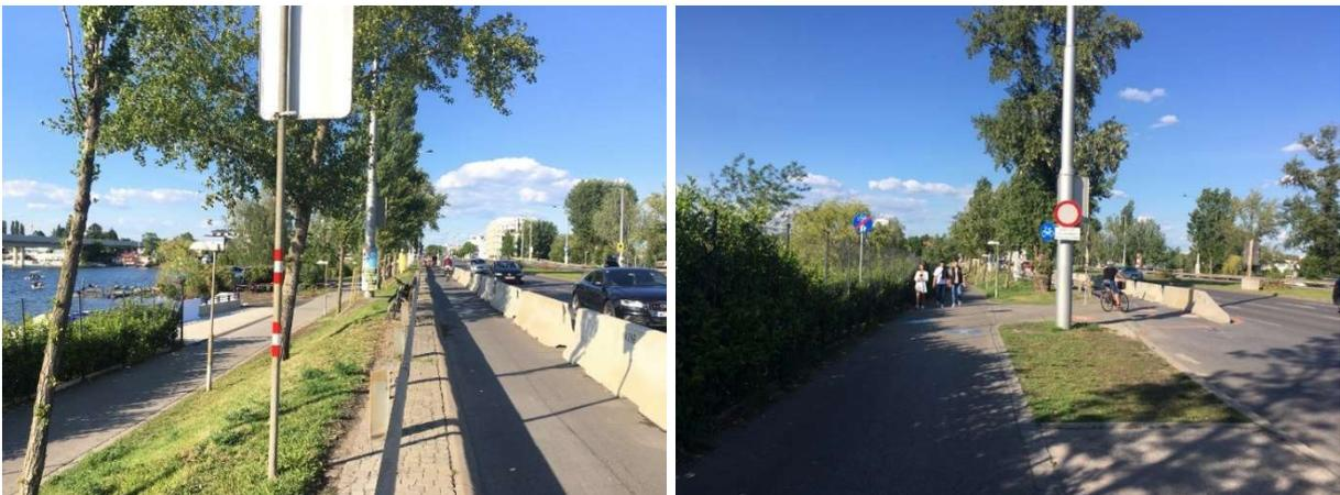
Abbildung 65: Wagramer Straße (links): links das Fahrverbot ausg. Rad, rechts der enge Pop-up-Zweirichtungsradweg, Wagramer Straße (rechts): zu enge Linienführung und mangelhafte Bodenmarkierung im Einfahrtsbereich des Pop-up-Radwegs stadtauswärts.
